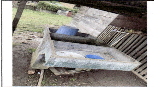
Foto 3: Pila de concreto muy desgastado y quebrada.
